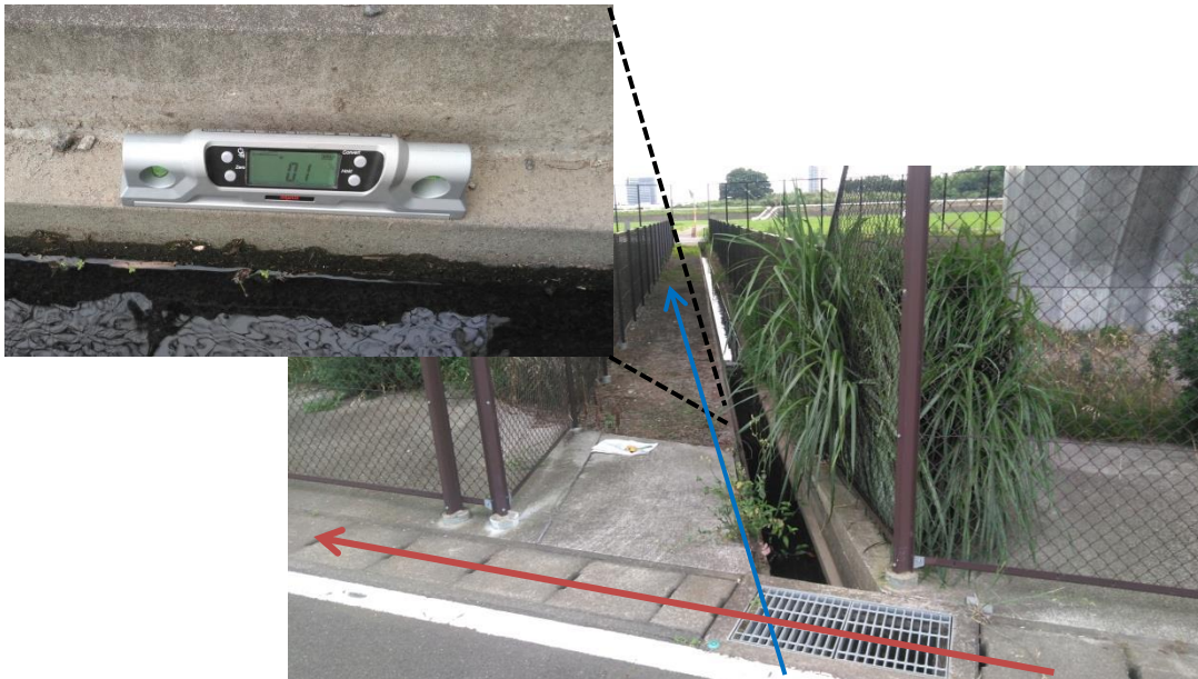
写真一 圈央道横断既設水路C
